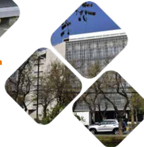
Laboratorios Edificio Eduardo Morales Santos
